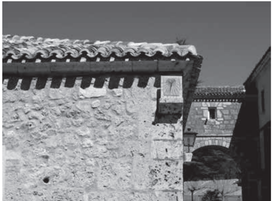
Edificio anexo al claustro de la hospedería, y antigua caballeriza.
