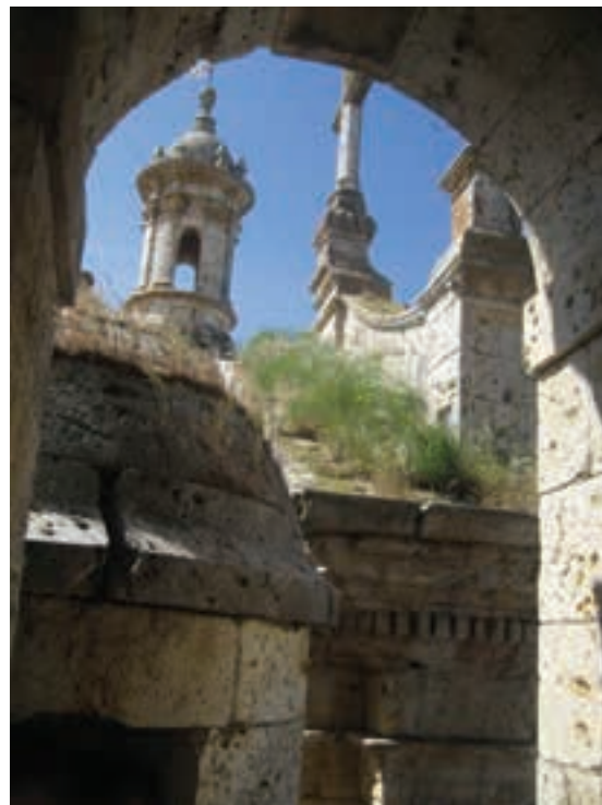
Acceso desde la cubierta de la iglesia hacia la zona superior de su portada y a las torres.
